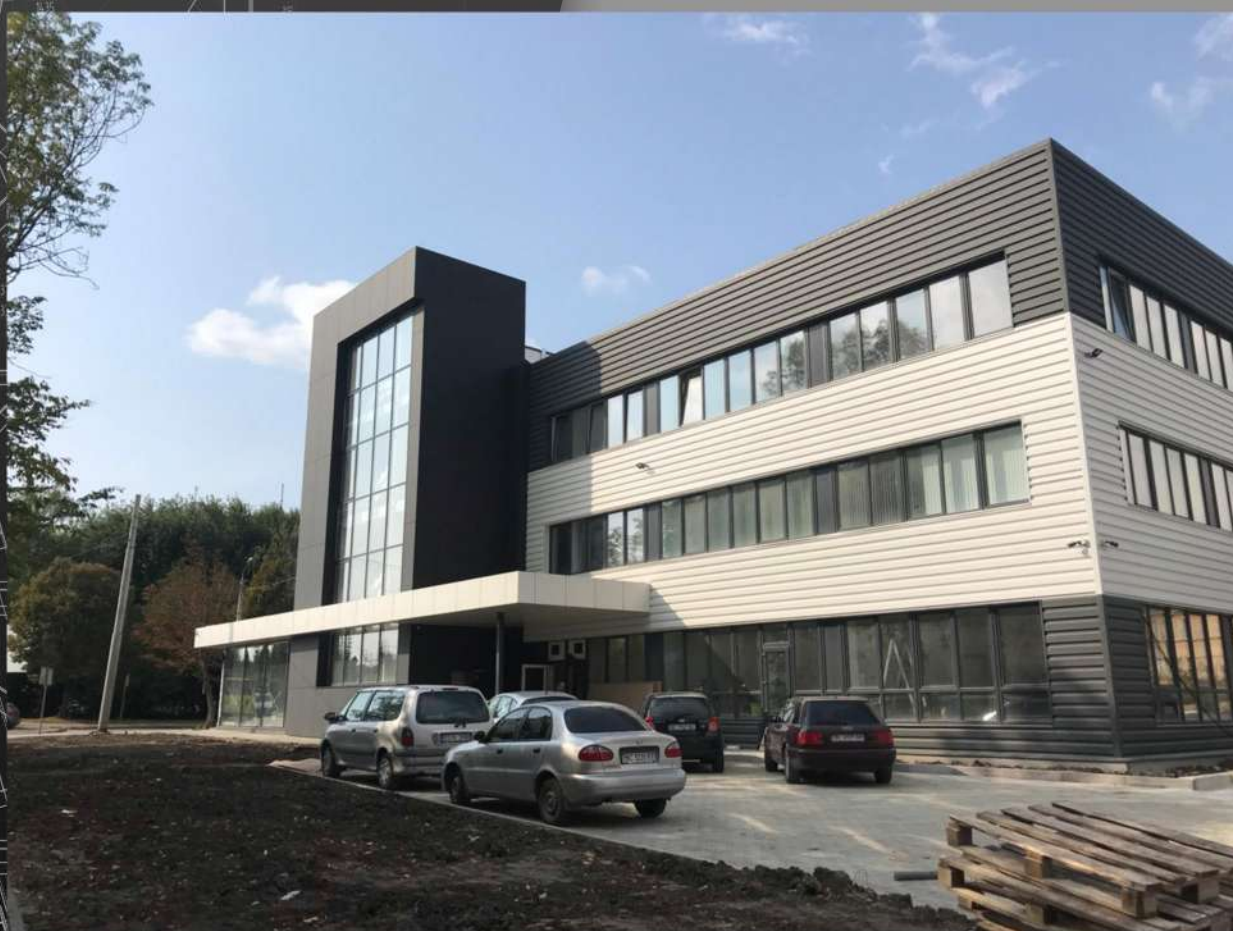
Офісні приміщення у м.Львів, вул. Козельницька
