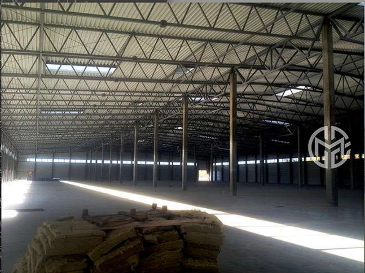
ТЗОВ "ПРО ТЕК ВІКНА УКРАЇНА"- складські приміщення, м. Львів
