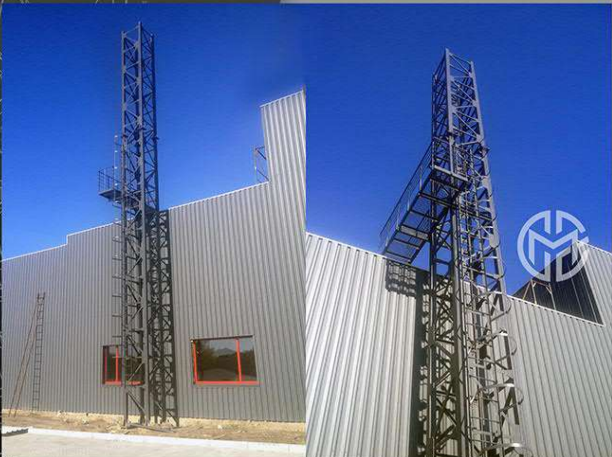
ТзОВ "ПРО ТЕК ВІКНА УКРАЇНА", м.Львів Несучі конструкції димової труби
