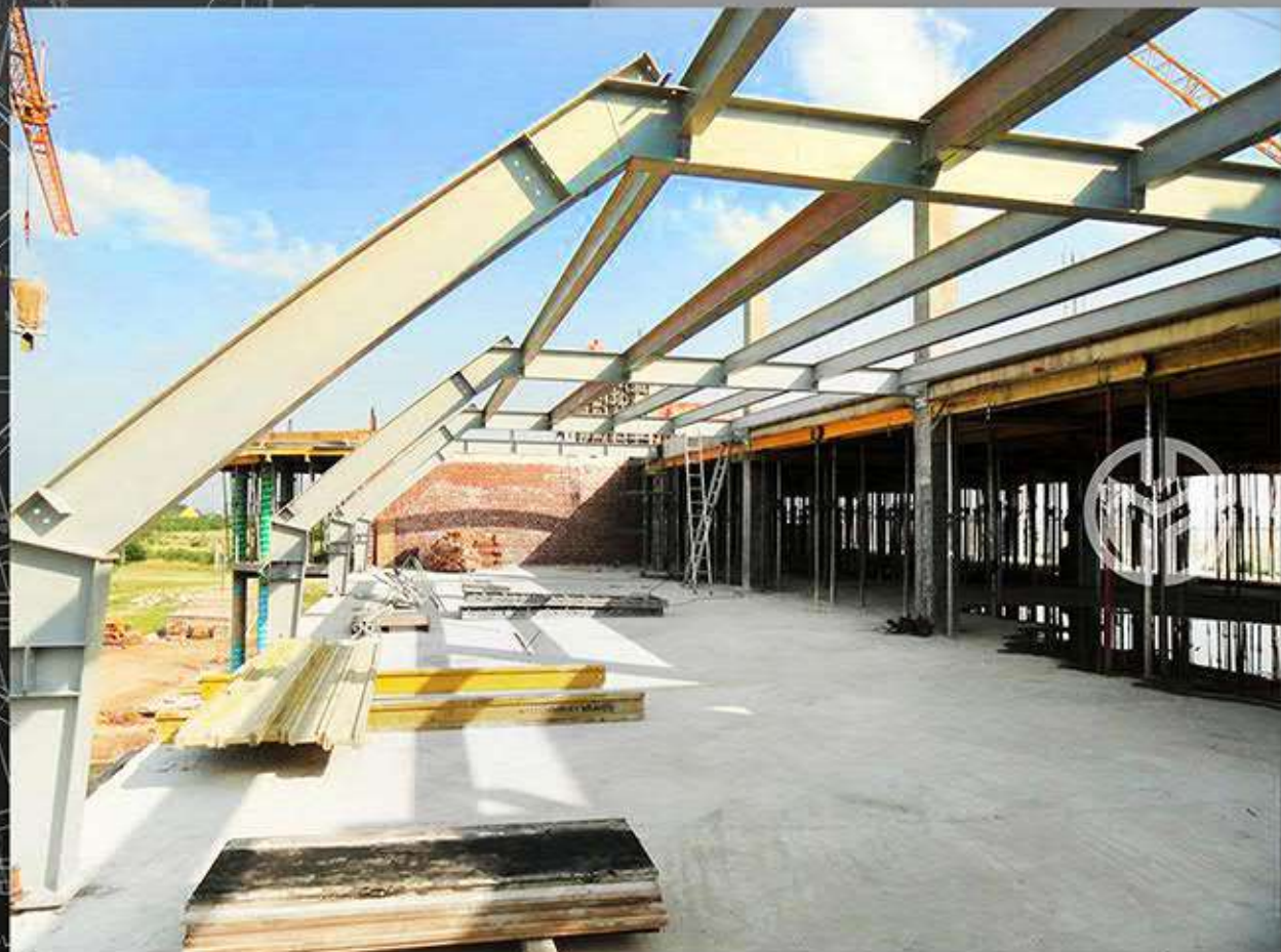
ТзОВ "Транс-Сервіс -1"- покрівля офісних приміщень, м.Львів
