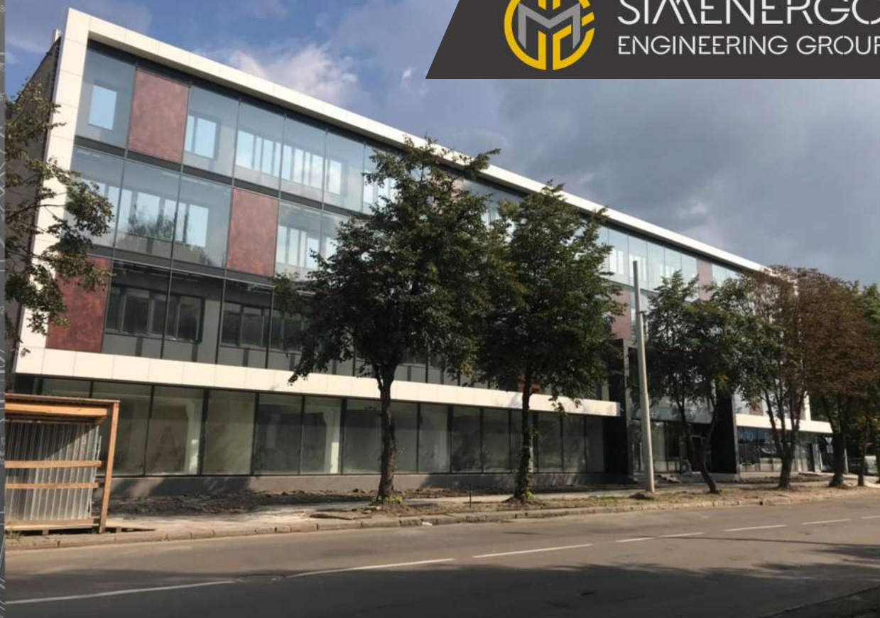
Офісні приміщення у м.Львів, вул. Козельницька
