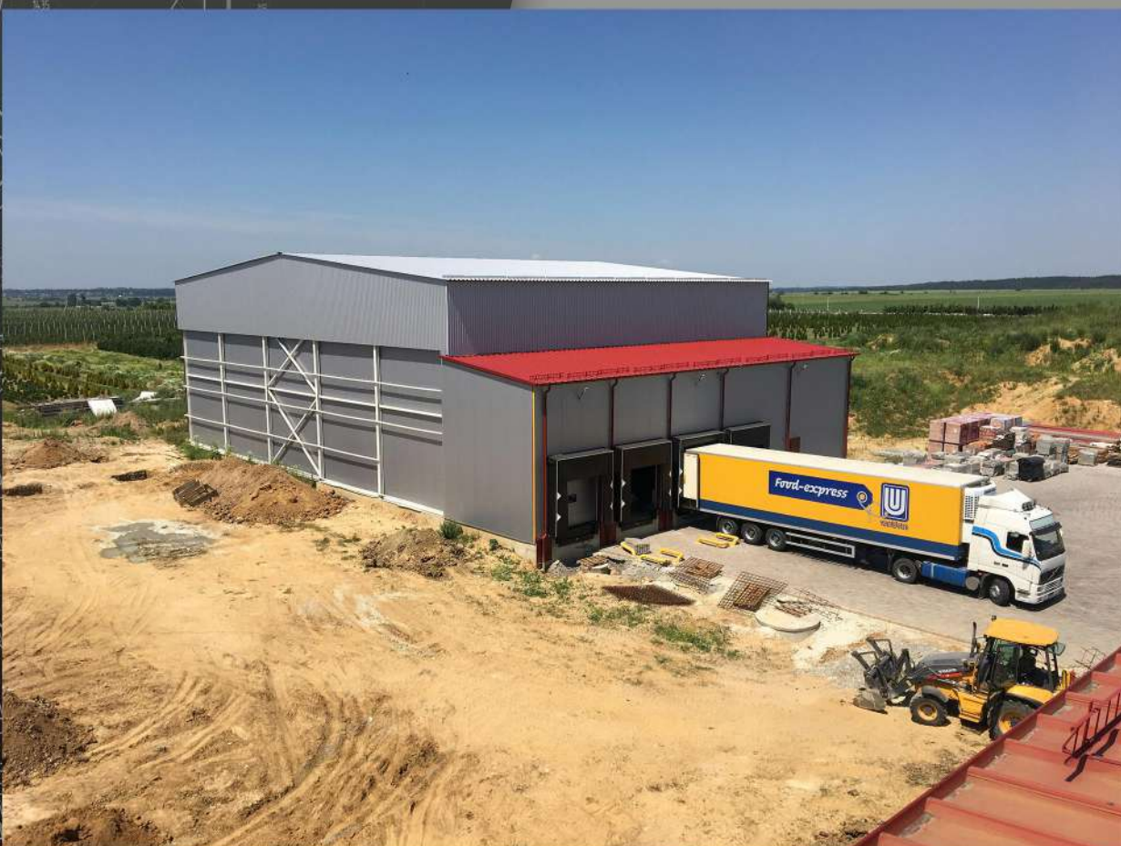
Холодильний склад, м.Городок
