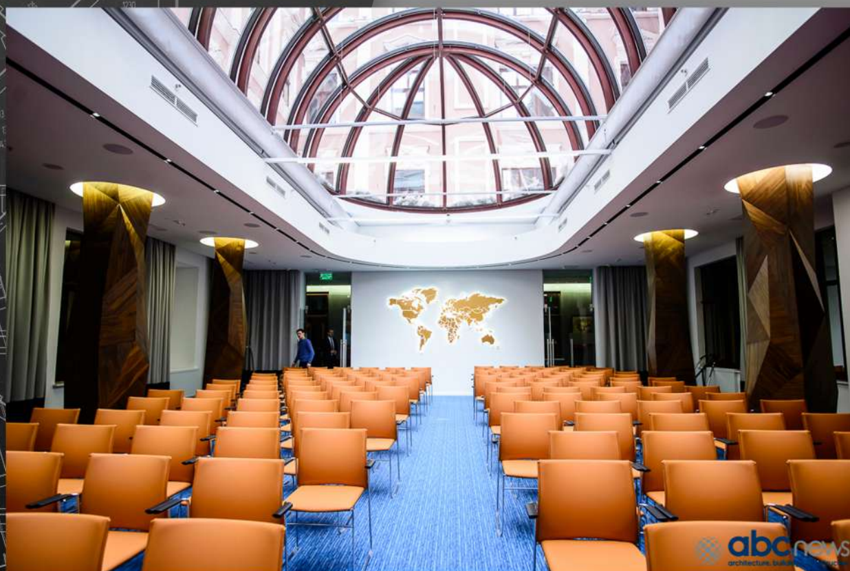
Несучі конструкції купола. Гранд готель м.Львів
