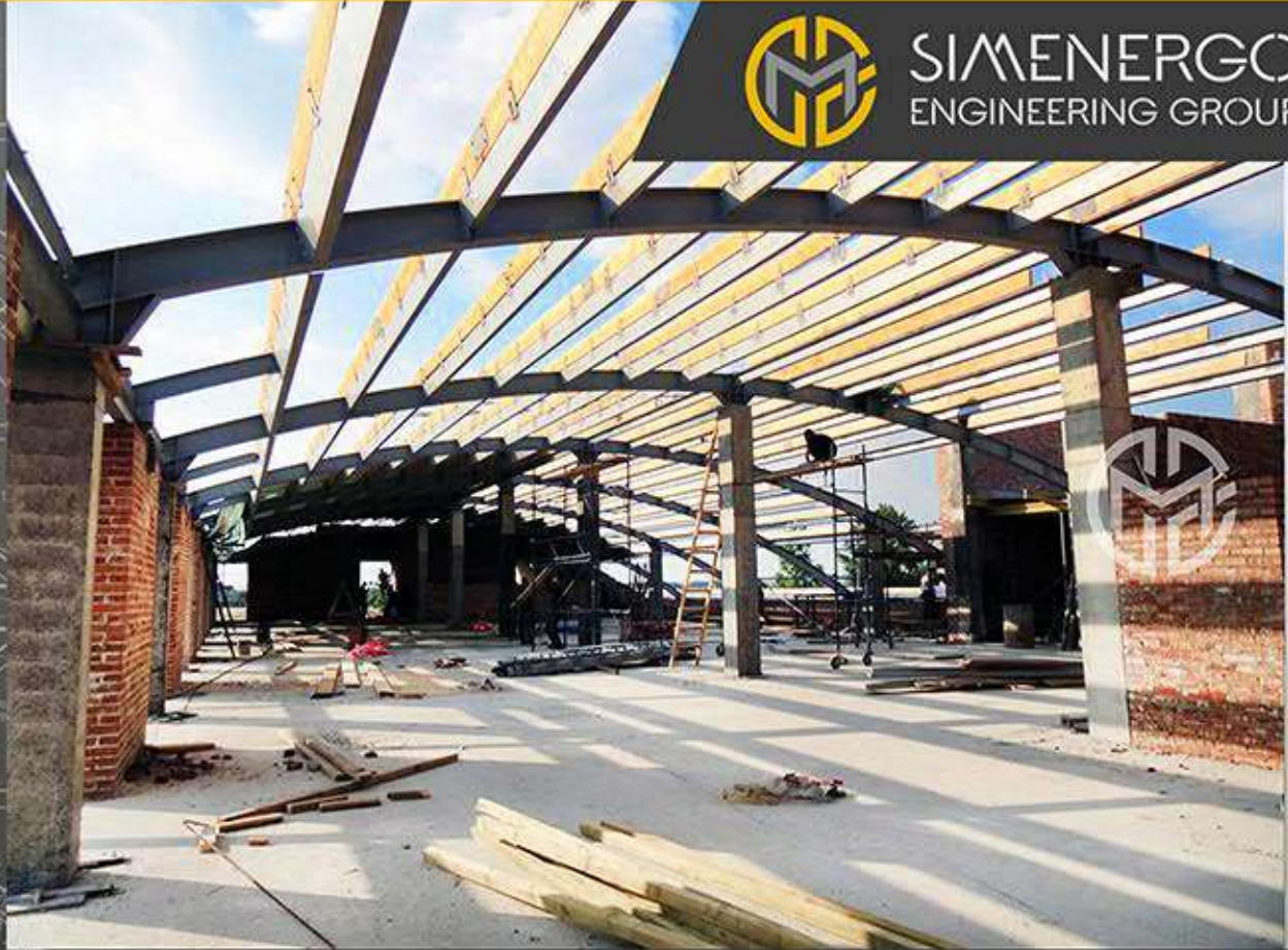
ТзОВ "Транс-Сервіс -1"- покрівля офісних приміщень, м.Львів
