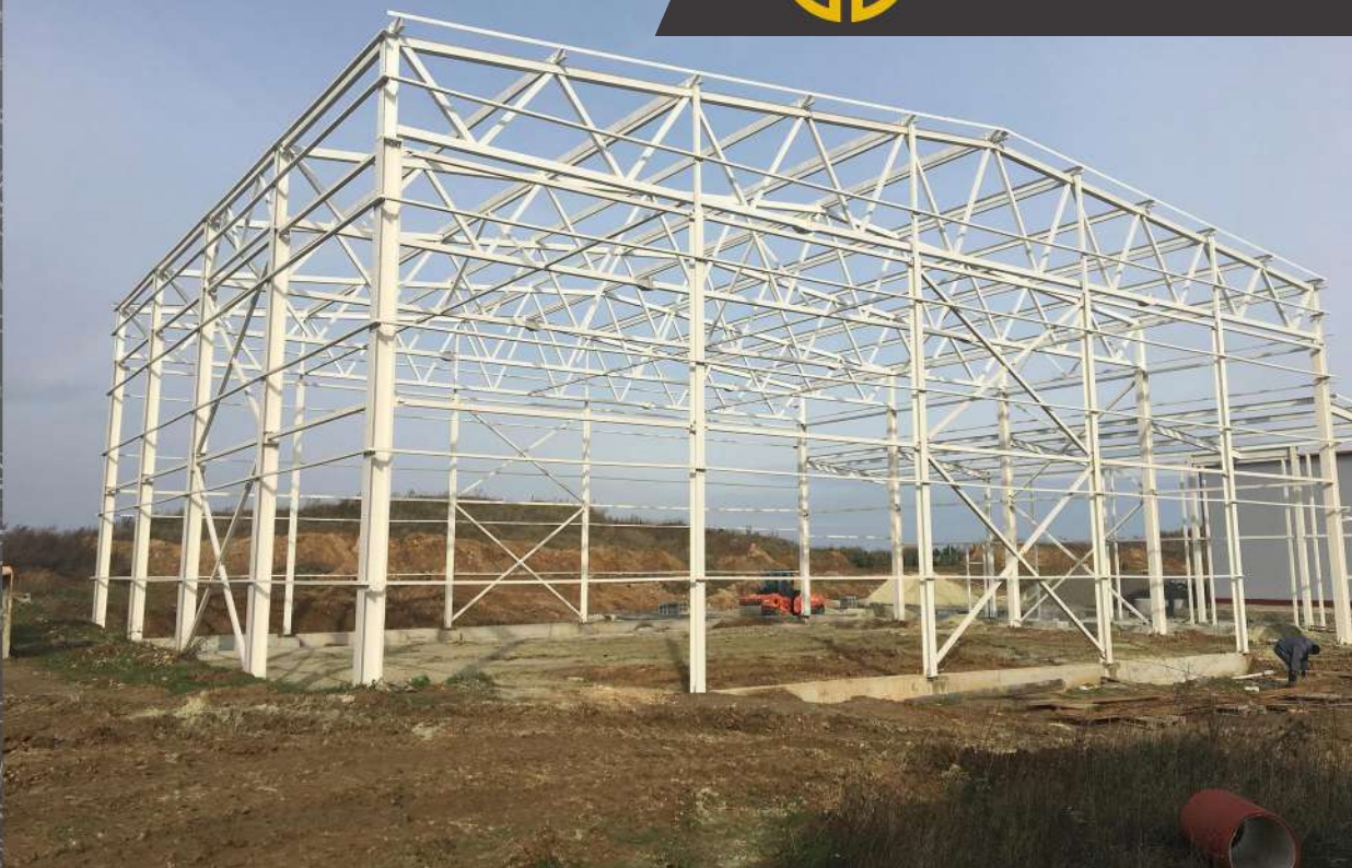
Холодильний склад, м.Городок
