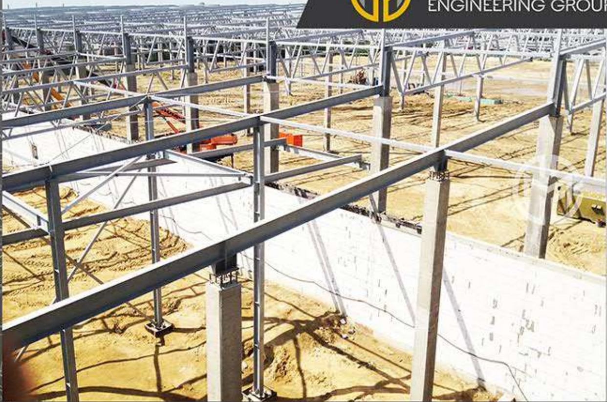
ТЗОВ "ПРО ТЕК ВІКНА УКРАЇНА", м. Львів Несучі конструкції каркасу складських приміщень
