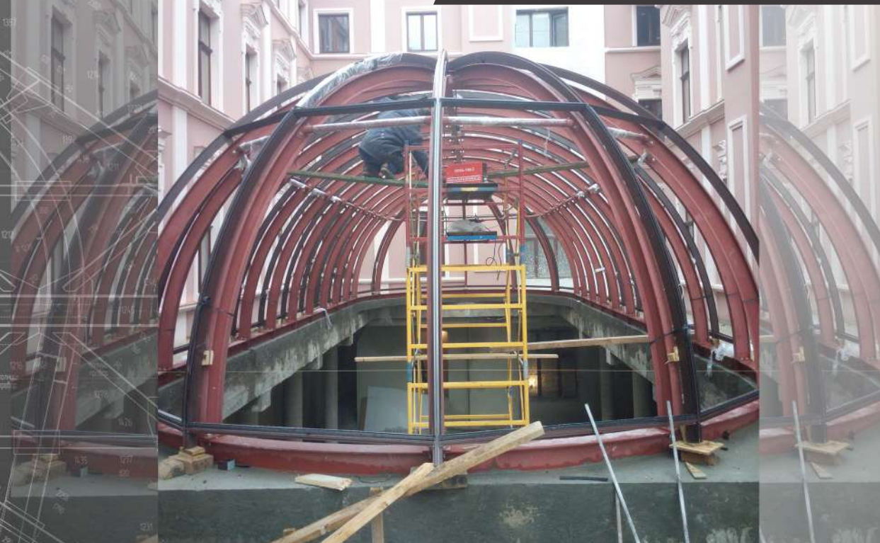
Несучі конструкції купола. Гранд готель м.Львів
